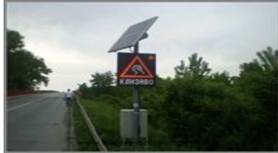
Слика 32. Соларна фотонапонска ћелија за напајање светлосне саобраћајне сигнализације
